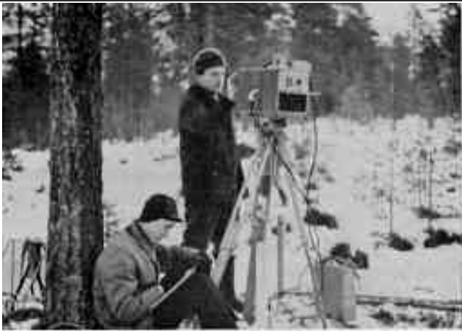
Fig. 2. Längdmätning med geodimeter i Umeå. Foto: J Ekenberg.
